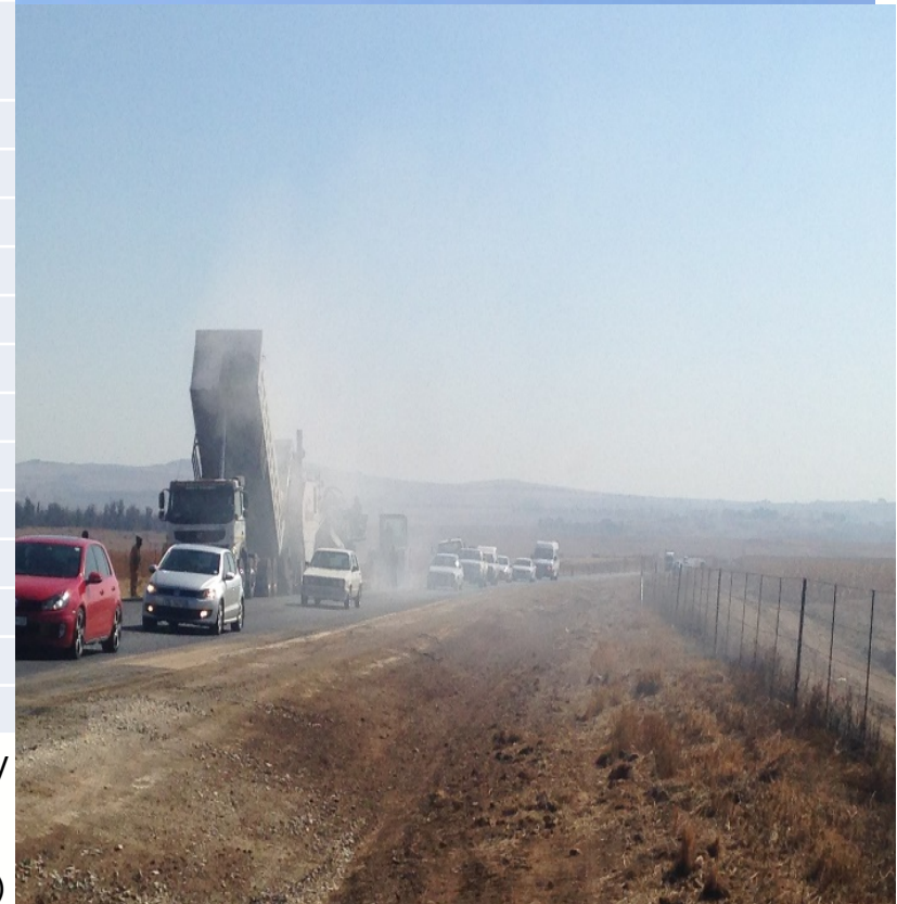
A-R1 paving - fumes
